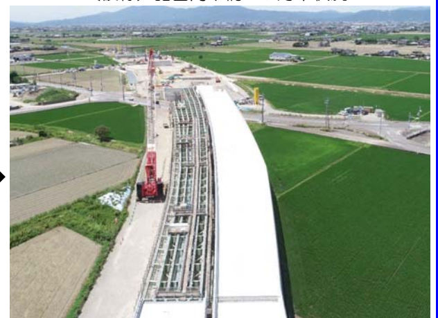
(仮称) 諸富高架橋ここまで進んでいます。
