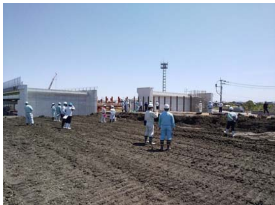
現場安全パトロール
