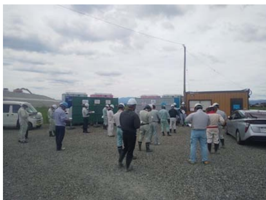
現場安全パトロール
