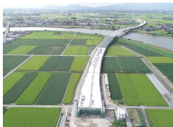
（仮称）早津江川橋 令和3年9月末状況
