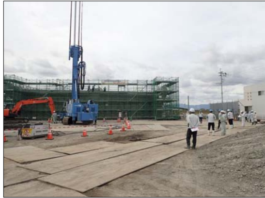
現場安全パトロール
