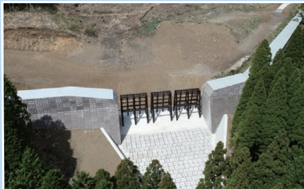
西小園川3第3砂防堰堤（阿蘇市）
