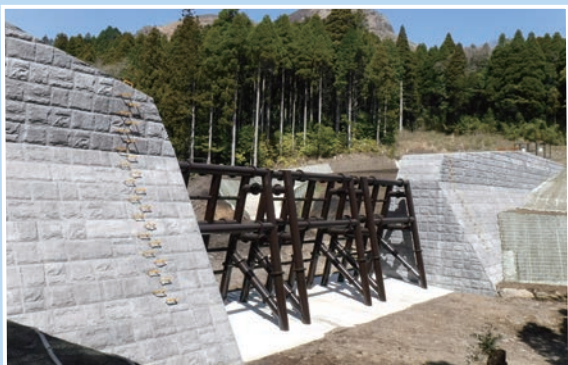
四ツ江川砂防堰堤（阿蘇市）
