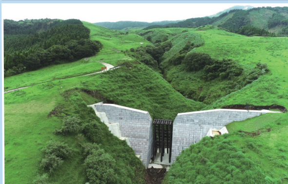
三王谷川1第3砂防堰堤（南阿蘇村）
