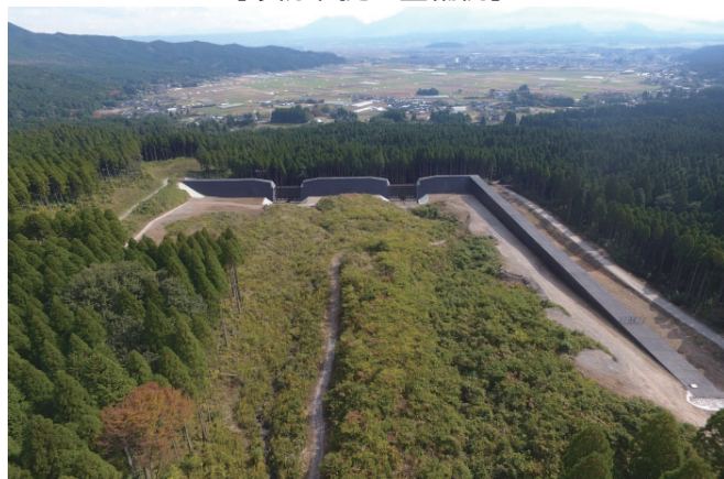
令和5年11月末完成 西湯浦川 1 砂防堰堤
