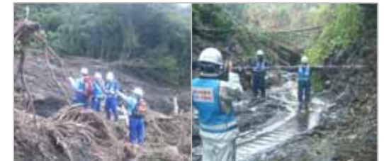
緊急点検状況 (H25年伊豆大島災害)
