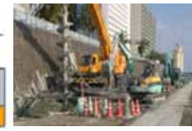
大淀川耐震対策(地盤改良)状況
