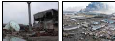
コンビナート被災の状況(H23年・出典:左 国土交通省,右 仙台市HP)
