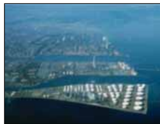
大分港の臨海部コンビナート等施設(出典:JX日鉱日石エネルギー(株)大分製油所提供)
