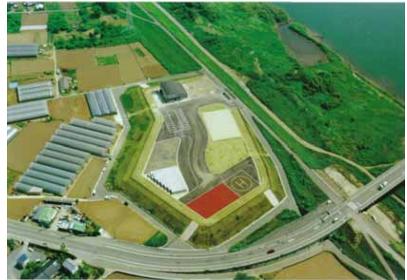
大野川防災ステーション
