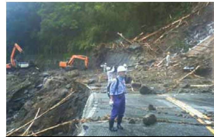
平成24年九州北部豪雨 国道57号滝室坂 斜面崩壊現場の診断状況
