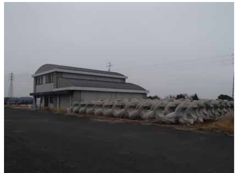
根固めブロック備蓄状況 (3 t 型)
