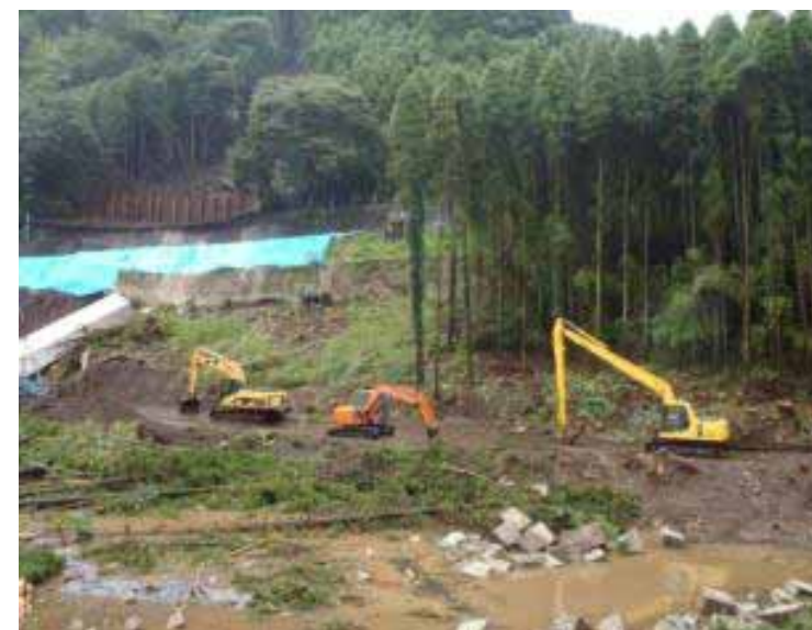
大規模災害時の応急復旧工事状況 (熊本県阿蘇市)
