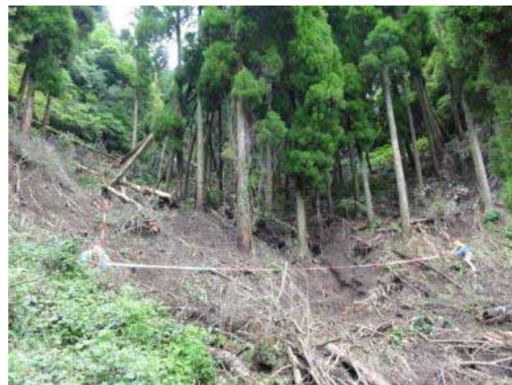
災害による斜面崩壊箇所の踏査状況 (熊本県阿蘇市)
