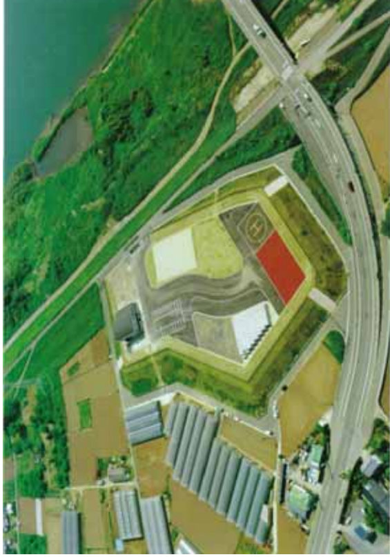
大野川防災ステーション
