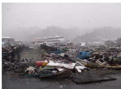
宮古港の被災状況
