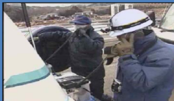
通信回線の設営作業
