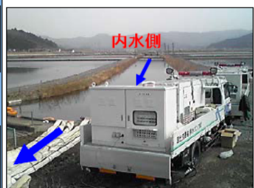
内水側：ポンプ車設置状況
