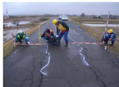
堤防被災調査【名取川】
