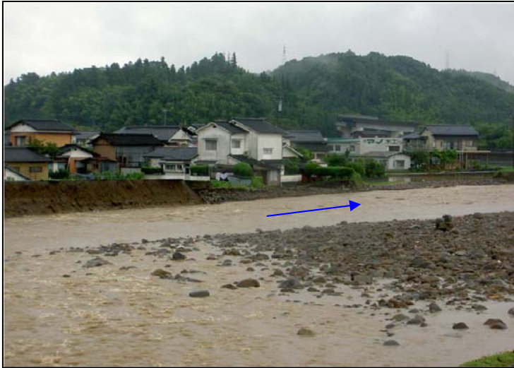
筑後川支川 花月川 5/800 左岸 (L=160m)
