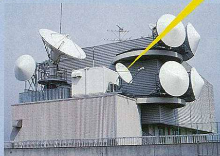
九州地方整備局に設置されているKu-SAT固定局
