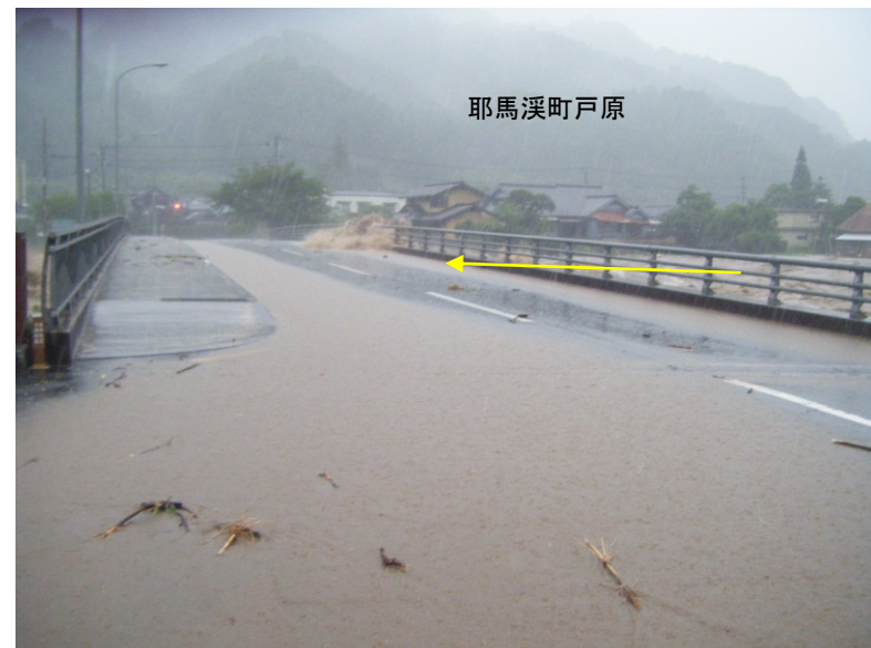
城井橋の越水状況
