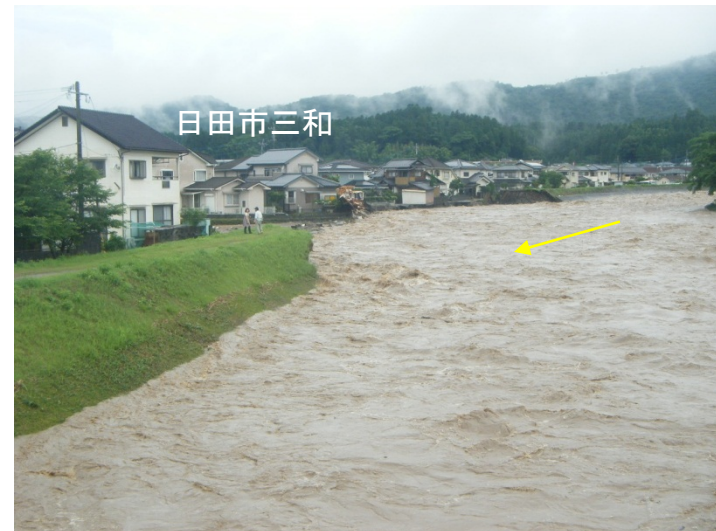
堤防決壊箇所を下流から望む(7月3日10:40頃) 26
