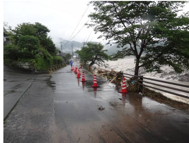
地蔵元橋下流右岸の越水痕跡 (7月3日17:00頃)
