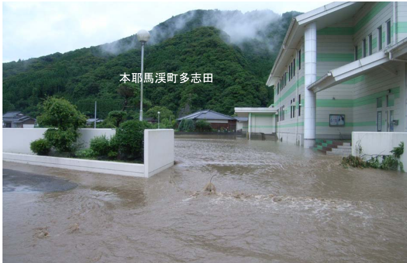
国道212号七仙橋上流右岸の浸水状況(7/3 10:50)
