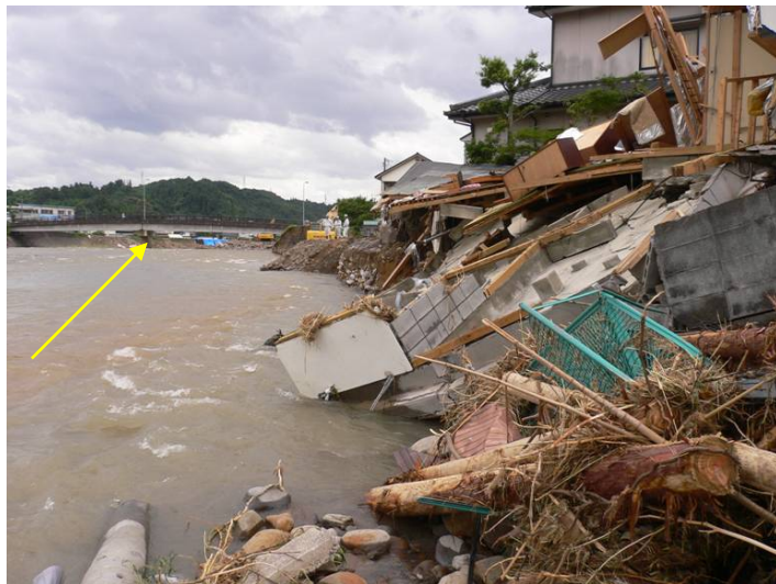
川沿いの家屋が倒壊し流失(7月5日撮影)
