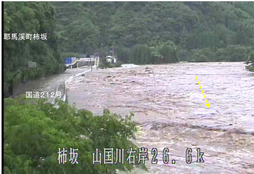
国道212号への越水状況(7/310:10)
