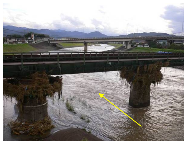
JR久大本線鉄道橋の洪水痕跡 (7月5日撮影)
