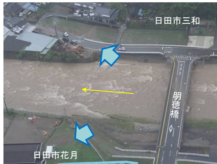
明德橋下流両岸の越水痕跡（7月3日16：20頃）
