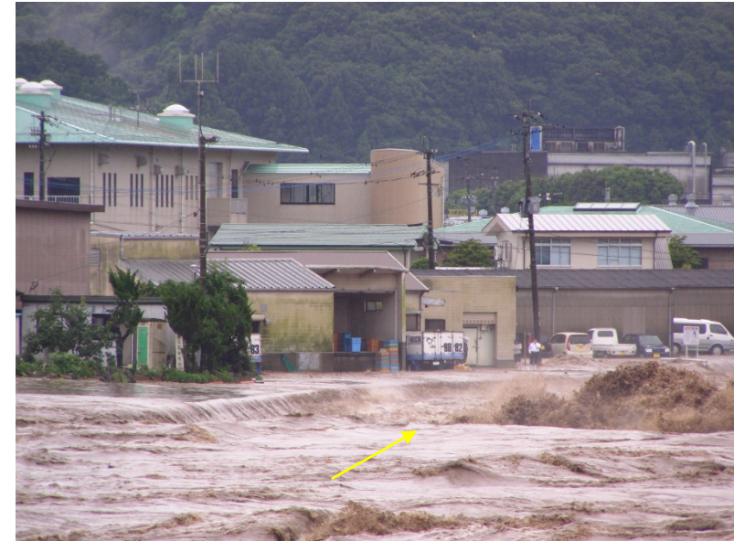
三郎丸橋下流左岸の氾濫流が花月川へ戻る状況(7月3日10:10頃)
