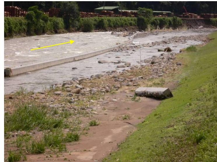
大幸橋下流右岸の高水敷洗掘状況(7月5日撮影)
