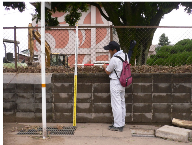
夕田橋上流右岸の北部中学校の浸水痕跡 (道路面より約1.2m)(7月5日撮影)
