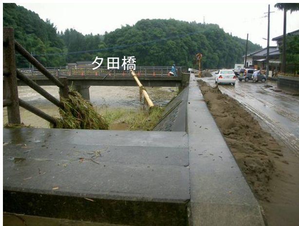
夕田橋上流右岸の越水痕跡と土砂堆積 (7月3日15:40頃)
