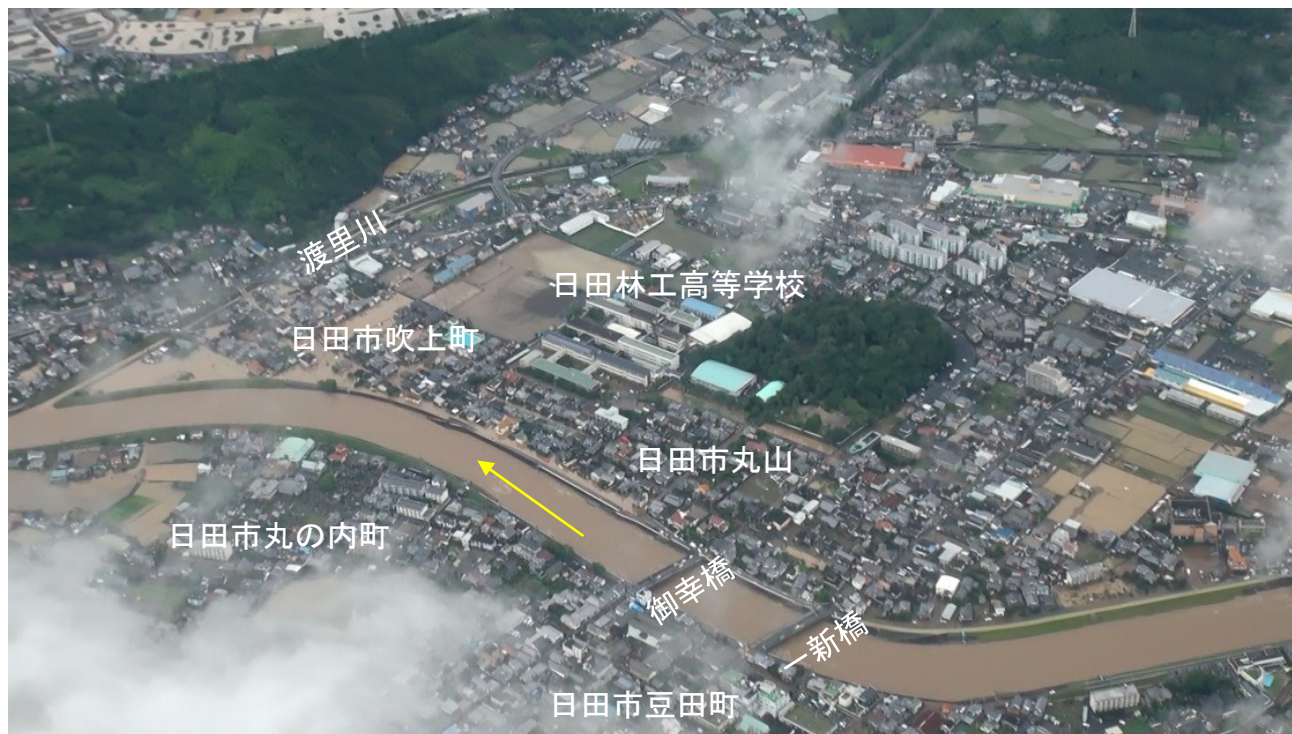
日田市街地中心部の状況(上流区間の氾濫流が右岸の市街地中心部に流下)(7月3日12:00頃)
