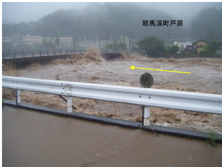
城井橋上流の流下状況
