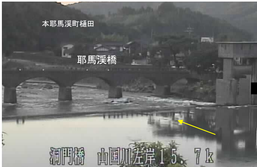
上流から耶馬溪橋を望む(平常時)
