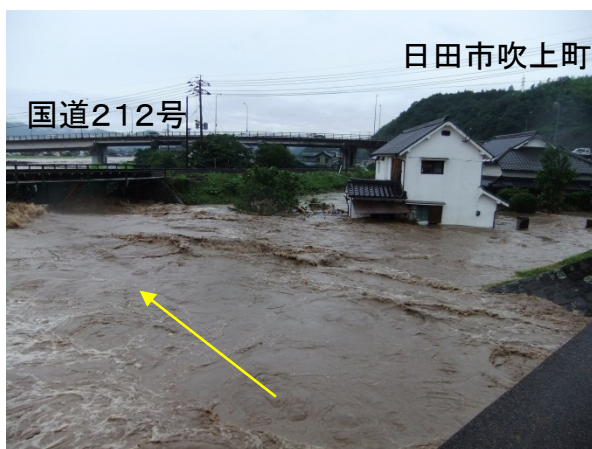
JR九大本線鉄道橋上流右岸の越水状況 (7月3日10:10頃)
