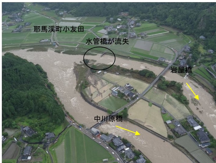
中川原橋上流左岸の越水状況(7/3 15:00)
