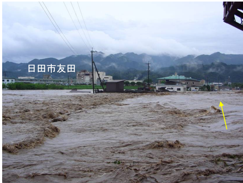
三郎丸橋下流左岸の越水状況(7月3日10:20頃)
