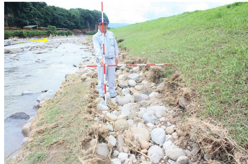
大幸橋下流右岸の高水敷と堤防のり尻の洗掘状況 (7月5日撮影)
