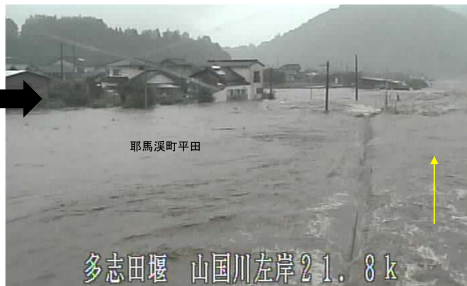
多志田堰左岸より下流を望む(越水状況)(7/3 9:00)
