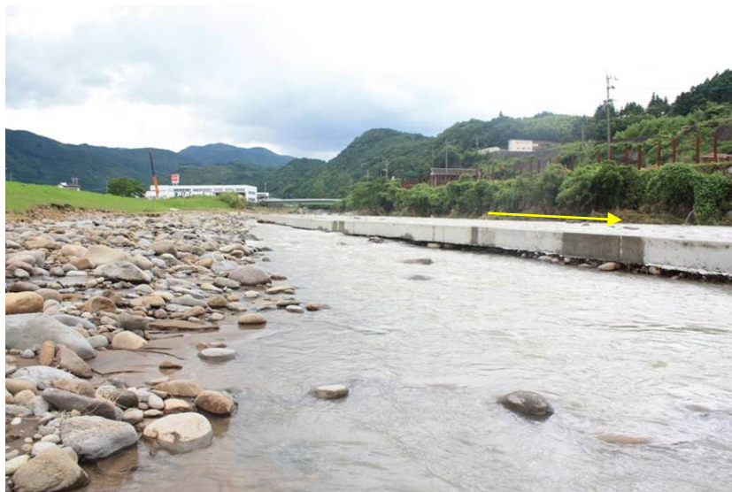
高水敷洗掘箇所を下流から望む(7月5日撮影)
