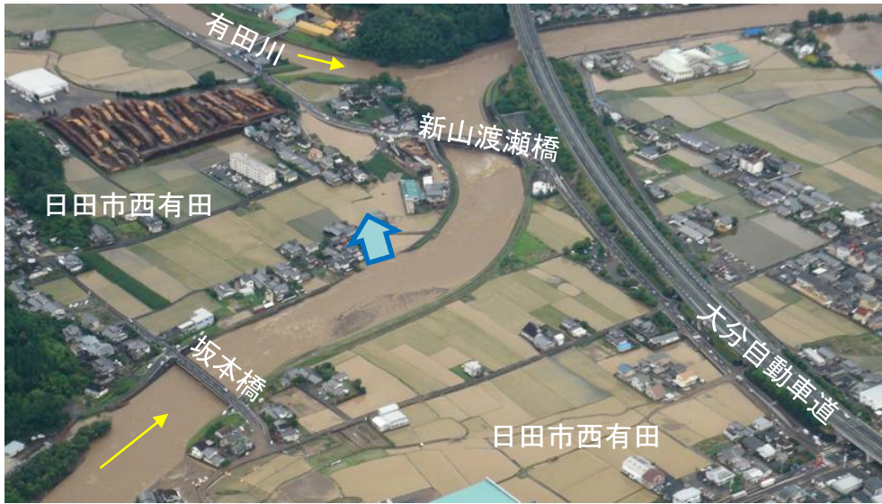
坂本橋下流左岸の堤防決壊状況(7月3日12:00頃)
