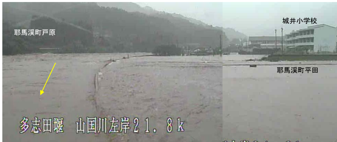
多志田堰左岸下流の越水状況(7/3 9:40)
