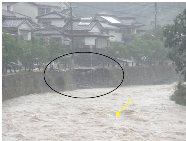
地蔵元橋下流右岸の護岸崩壊状況 (7月3日16:50頃)
