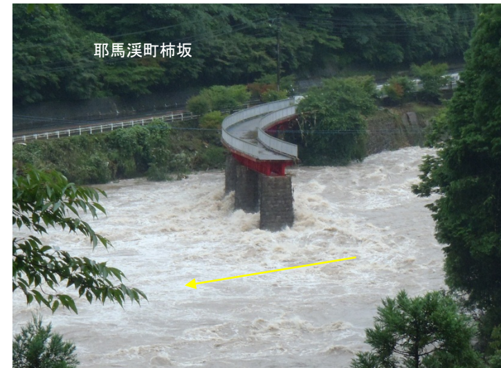
左岸側より第2山国川橋を望む(7/3 14:30) 3 3
