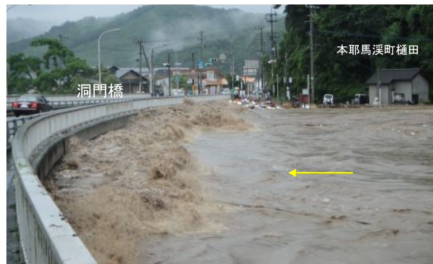
洞門橋上流の越水状況(7/3 10:10)
