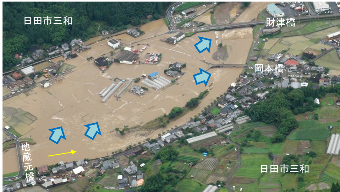
地蔵元橋下流左岸の越水状況（7月3日11:50頃）
