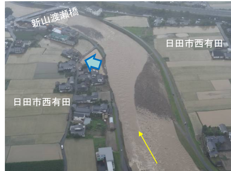
堤防決壊状況を上流から望む(7月3日16:00頃)
