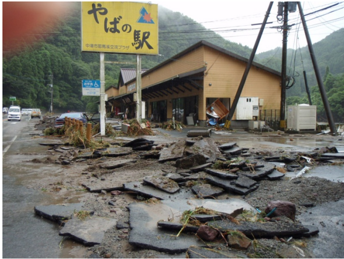
商業施設の浸水被害状況(耶馬溪町柿坂)(7/3 14:10)
