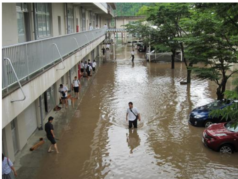
日田林工高等学校敷地内の浸水状況(学校からの提供)
