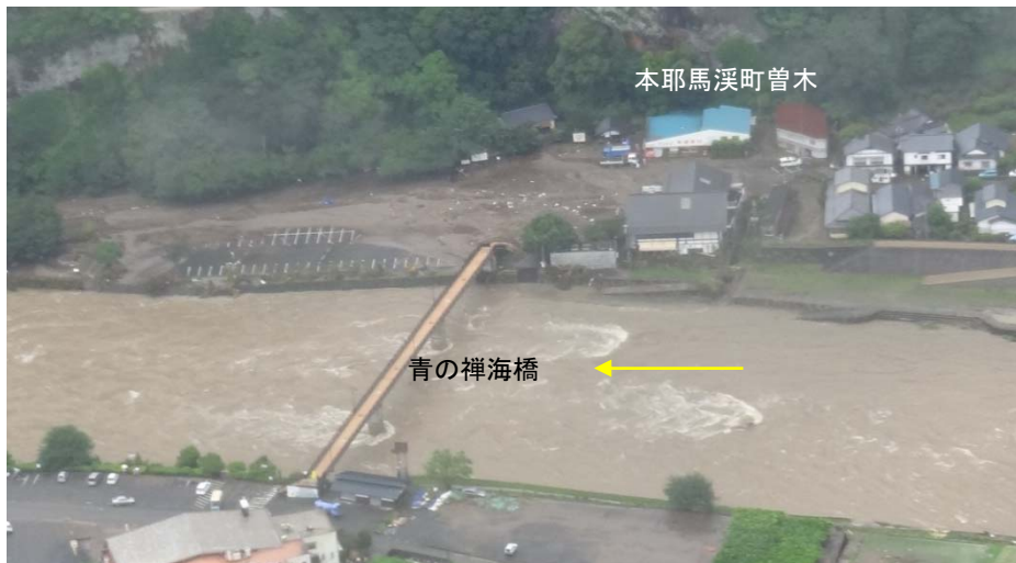
青の禅海橋付近の浸水痕跡(7/3 15:20)
