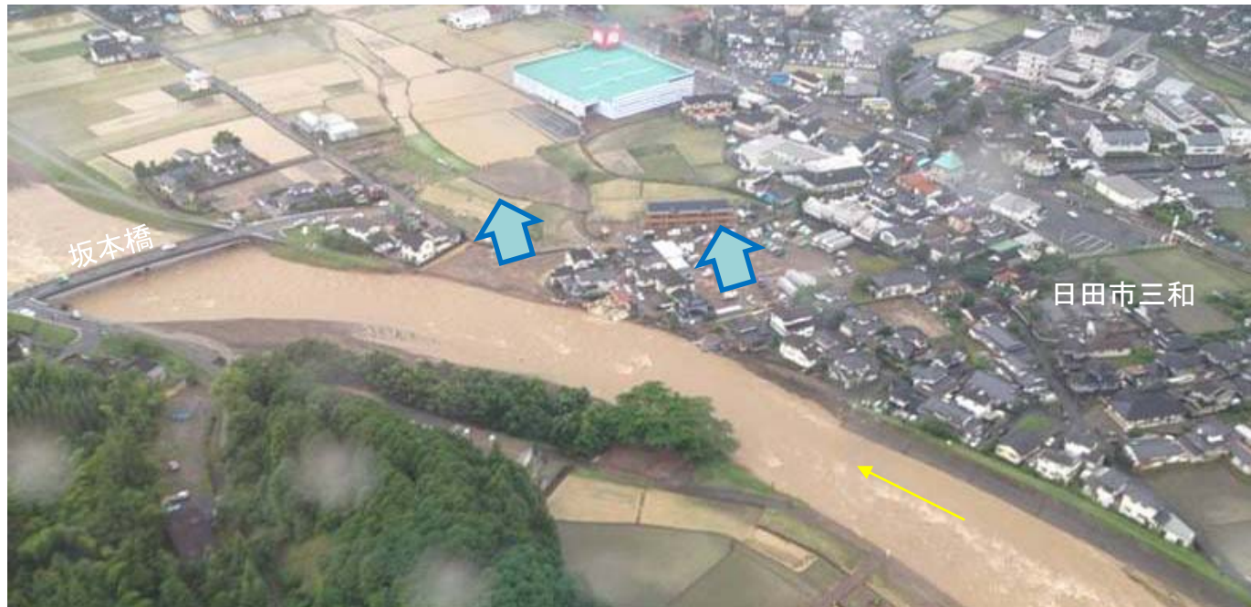
坂本橋上流右岸の堤防決壊状況(7月3日12:10頃)
