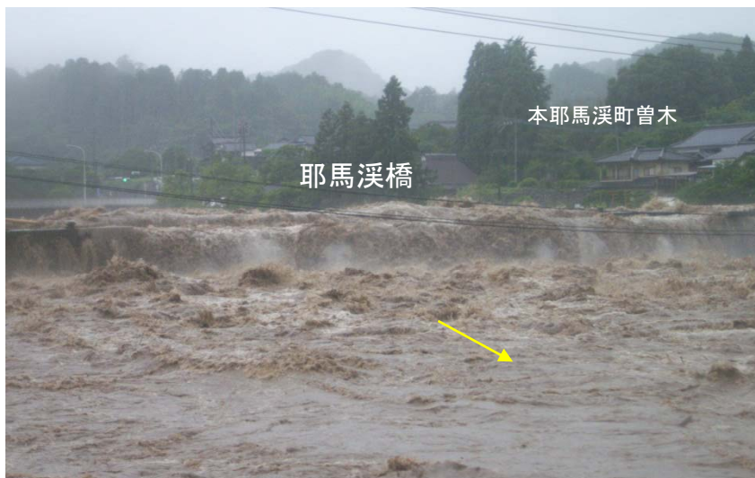
耶馬溪橋付近の流下状況(7/3 9:50)
