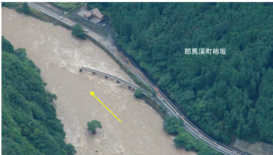
第2山国川橋(自転車道)の橋梁流失状況(7/3 12:20)
