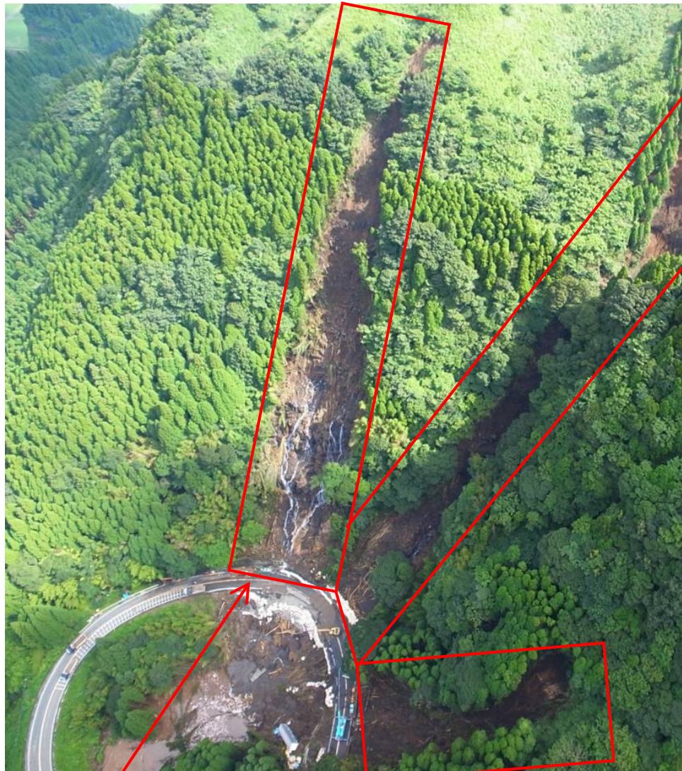
崩壊斜面の高さ: 約170m、幅: 約30m
