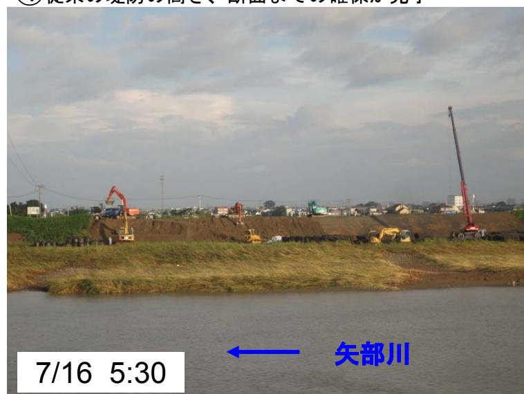
④従来の堤防の高さ、断面までの確保が完了
