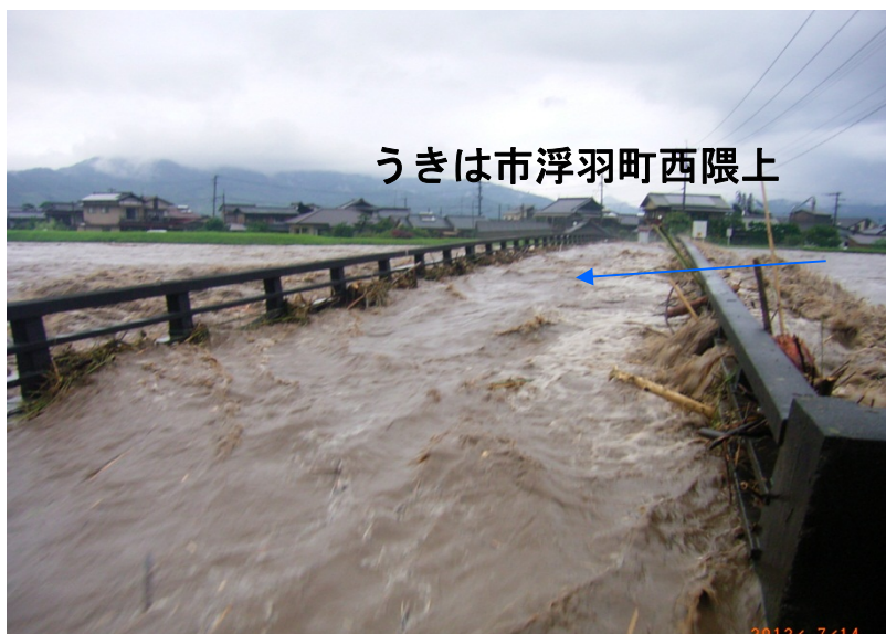
隈上川1k000付近(下御所橋) 7月14日 7:10頃
