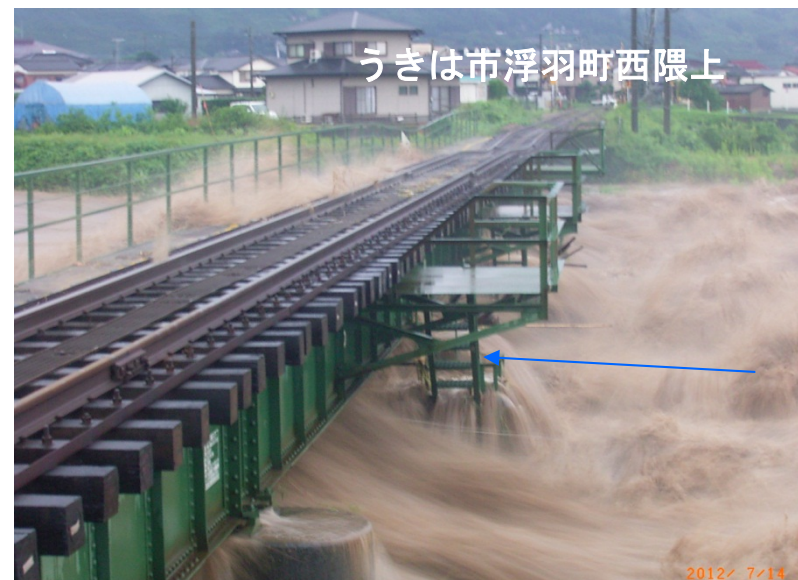
隈上川1k800付近(久大本線鉄道橋) 7月14日 7:00頃
