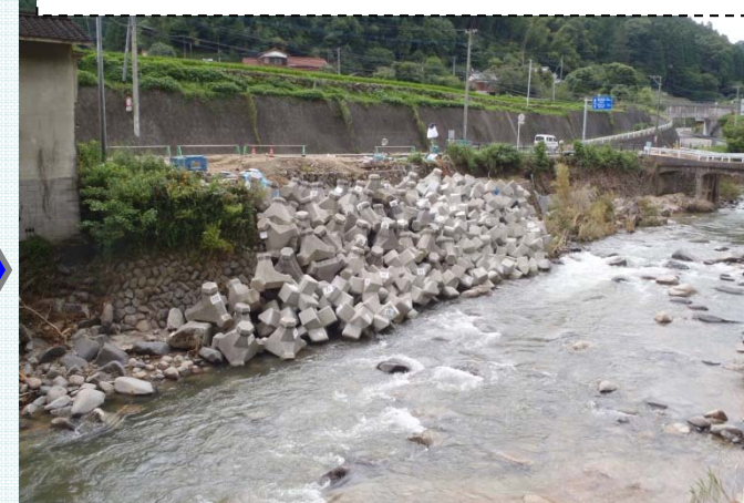
7月19日12時00分 施工完了
