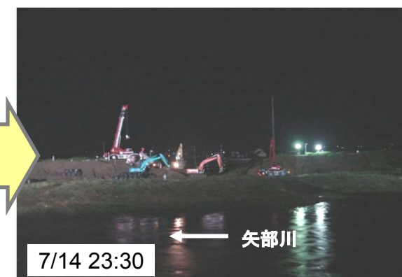
⑤応急復旧完了（堤防表面を補強する法覆工が完了）
