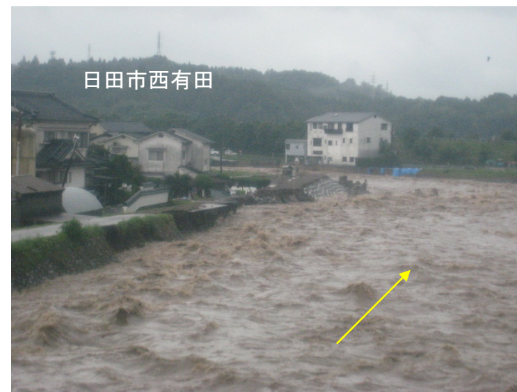
坂本橋下流の堤防決壊箇所を上流から望む(7/14 8:40)
