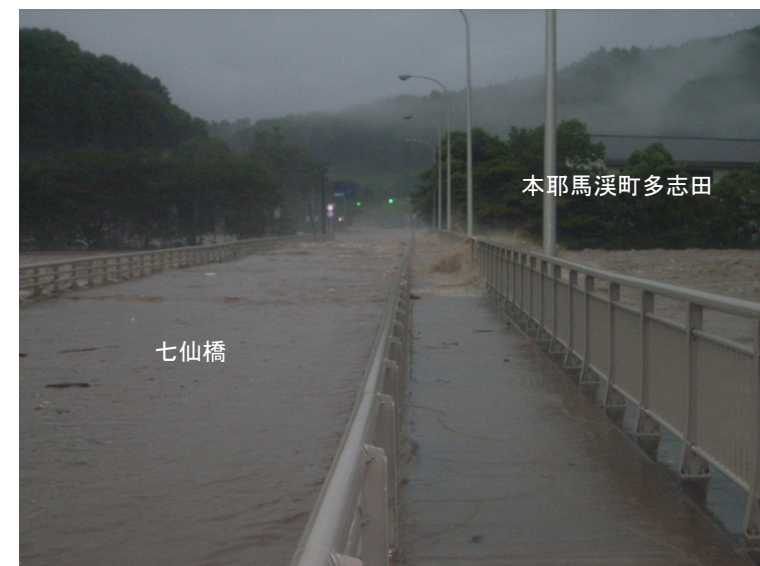
国道212号七仙橋上流右岸の越水状況(7/14 7:20)
