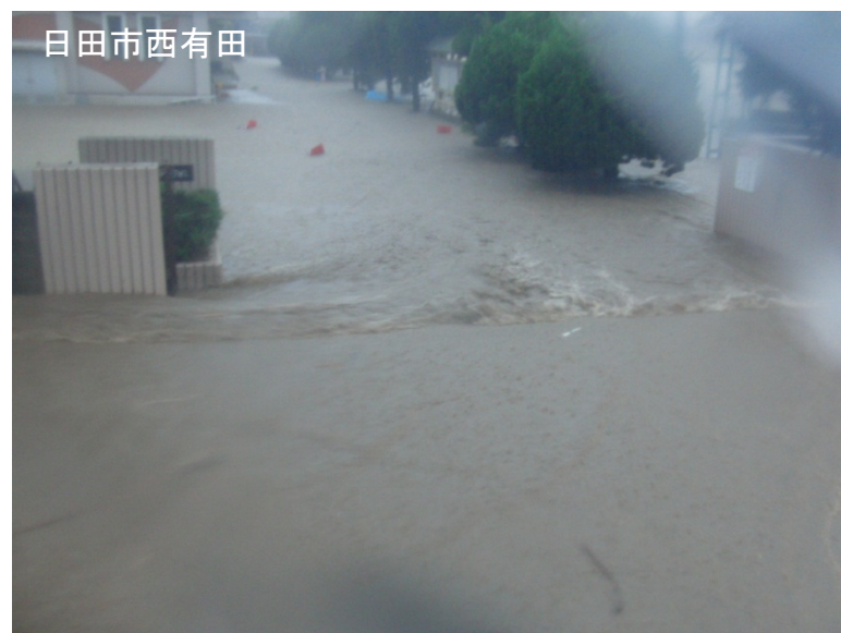
夕田橋上流右岸の北部中学校の浸水状況(7/14 8:00)
