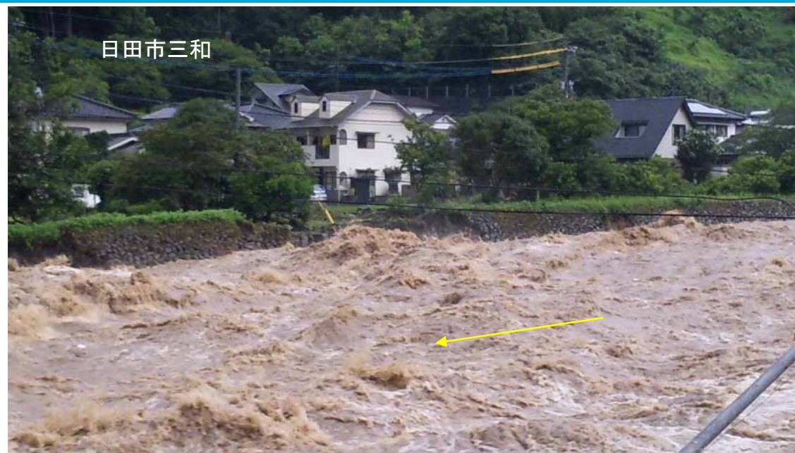
明德橋下流右岸の護岸崩壊状況(7/14 8:10)
