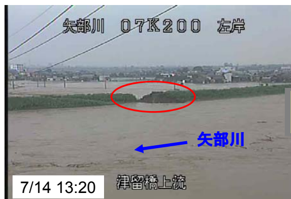
④従来の堤防の高さ、断面までの確保が完了
