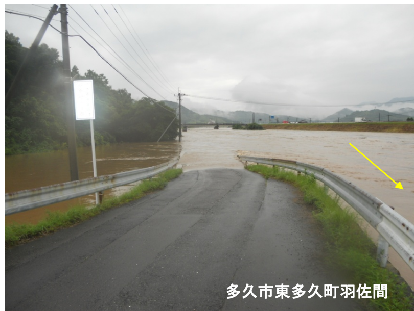
牛津川14k600右岸（多久市東多久町羽佐間）の状況 （7/13 17:00頃）
