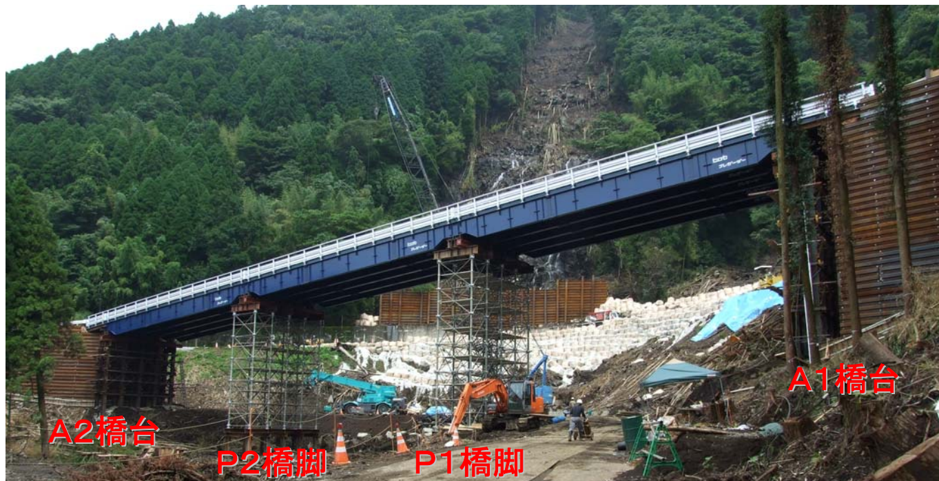
仮橋上部工(桁架設)完了
