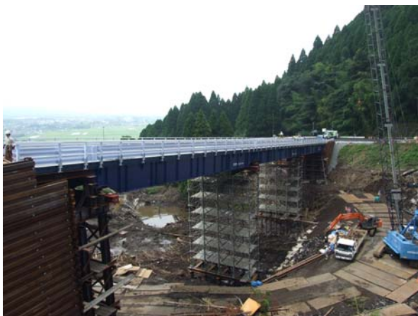
仮橋上部工(桁架設)完了
