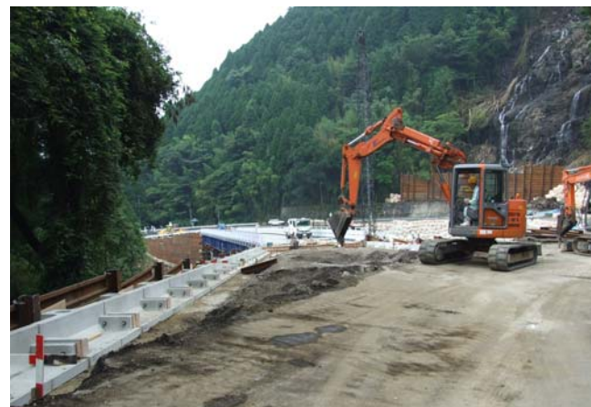
取付盛土工(A1側)完了
