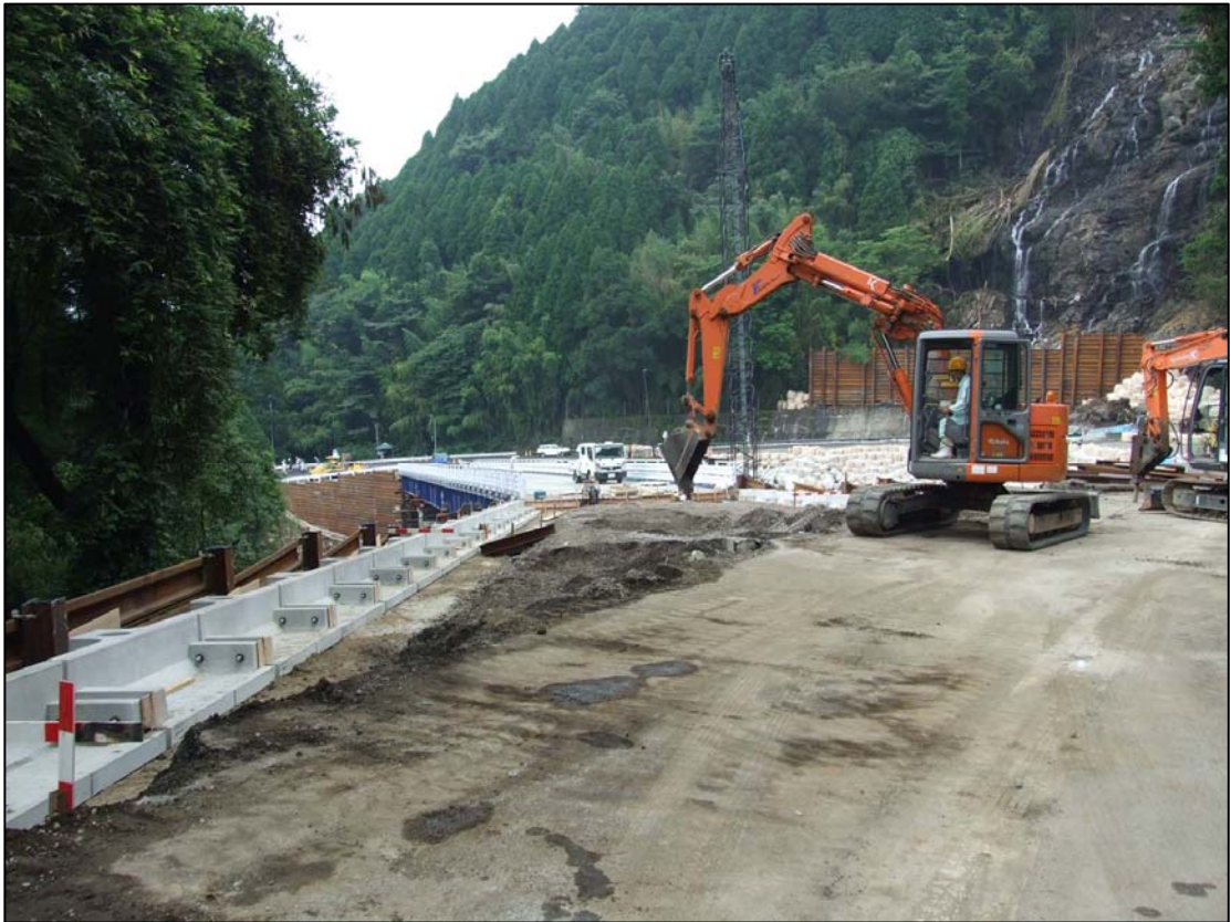
【写真－ 9】 取付盛土工事完了
