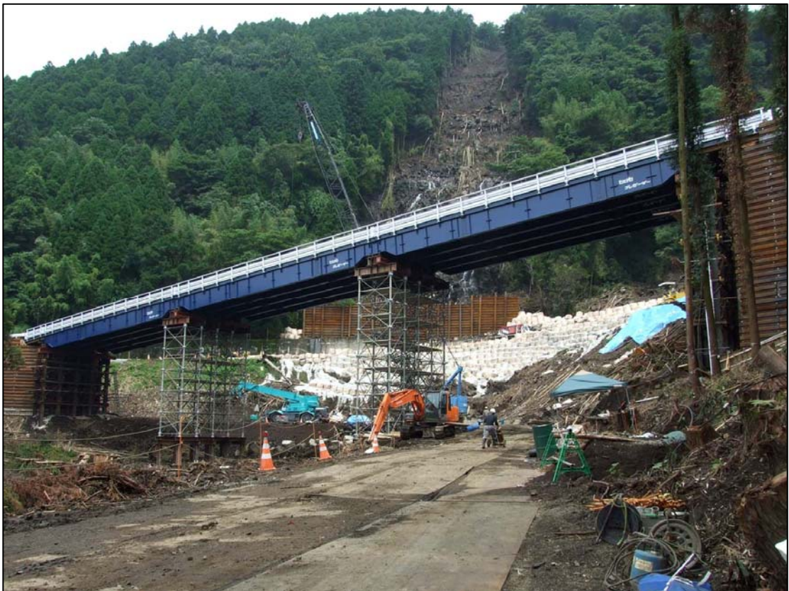
【写真－ 8】 仮橋の上部工（橋桁）工事完了
