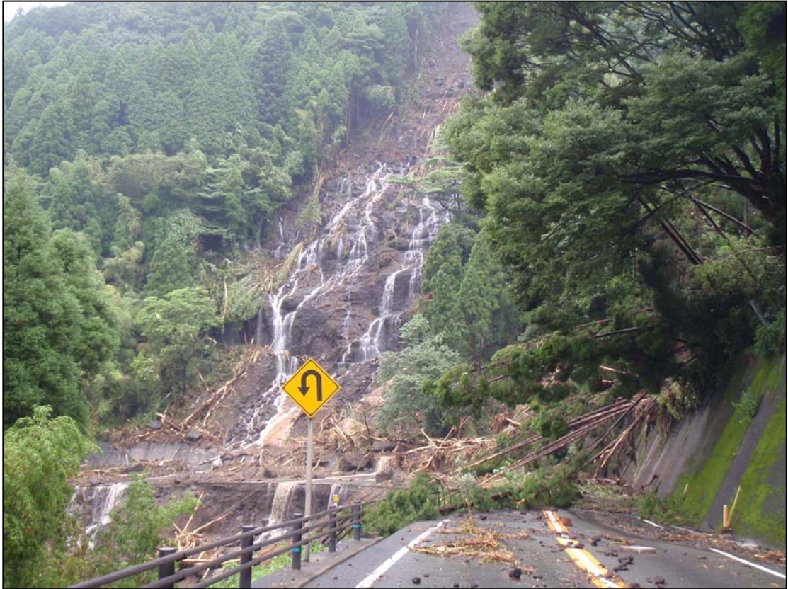
【写真－1】 斜面崩壊直後
