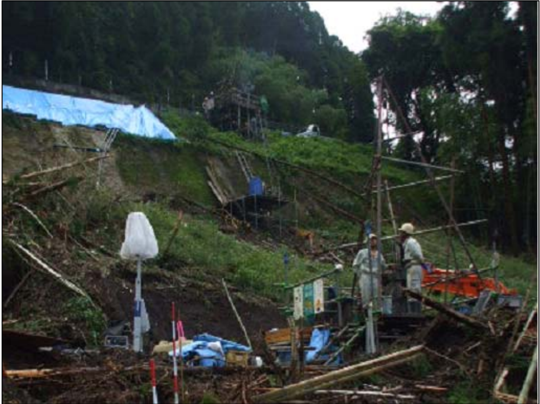
【写真－５】 地質調査ボーリング
