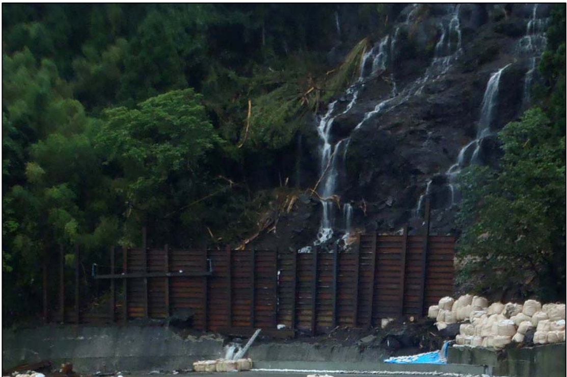
【写真－2】 斜面崩壊に対する応急措置
