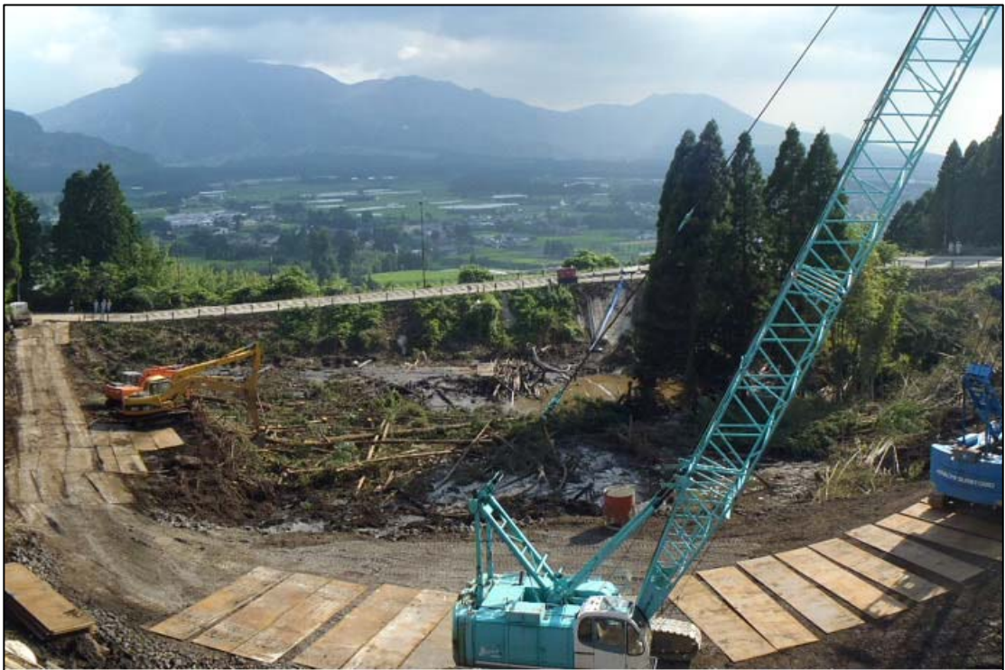
【写真－６】 工事用進入路・仮橋施工ヤードの整備完了
