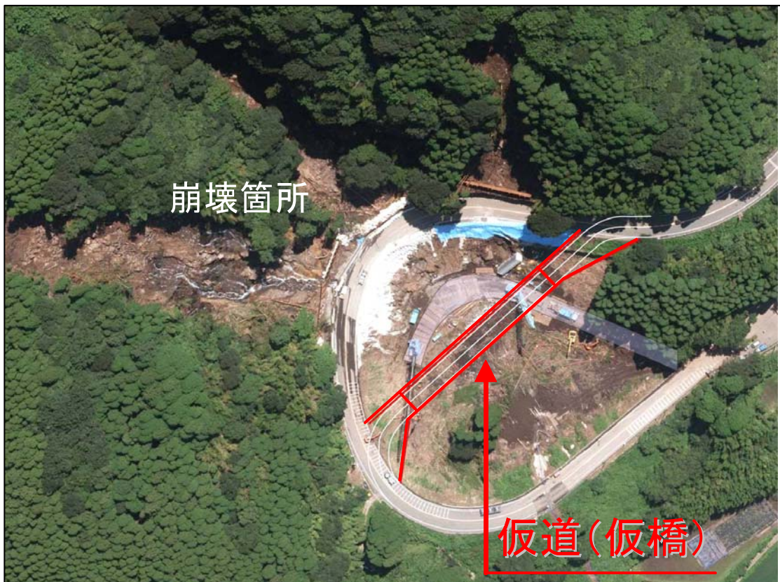
【写真－4】 崩壊箇所を回避し、仮道（仮橋）を設置
