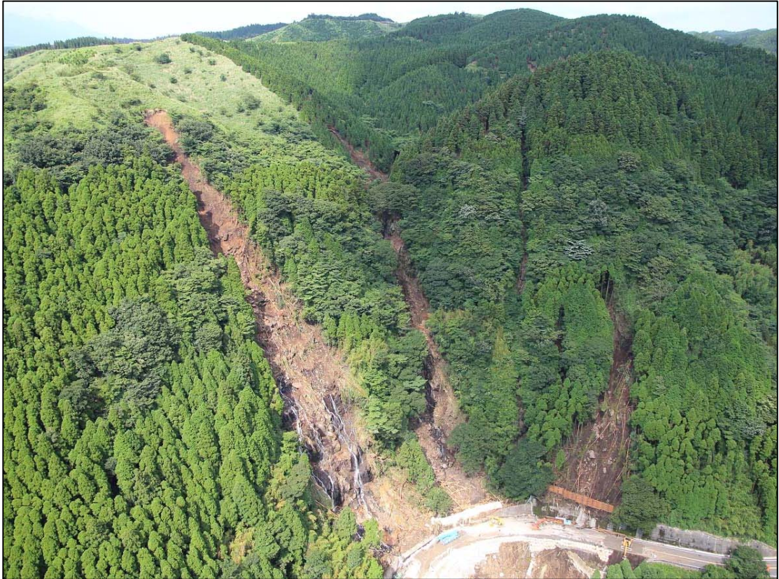
【写真－3】 バルーンによる斜面調査
