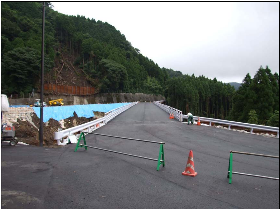
【写真－ 10】 舗装、防護柵設置工事完了
