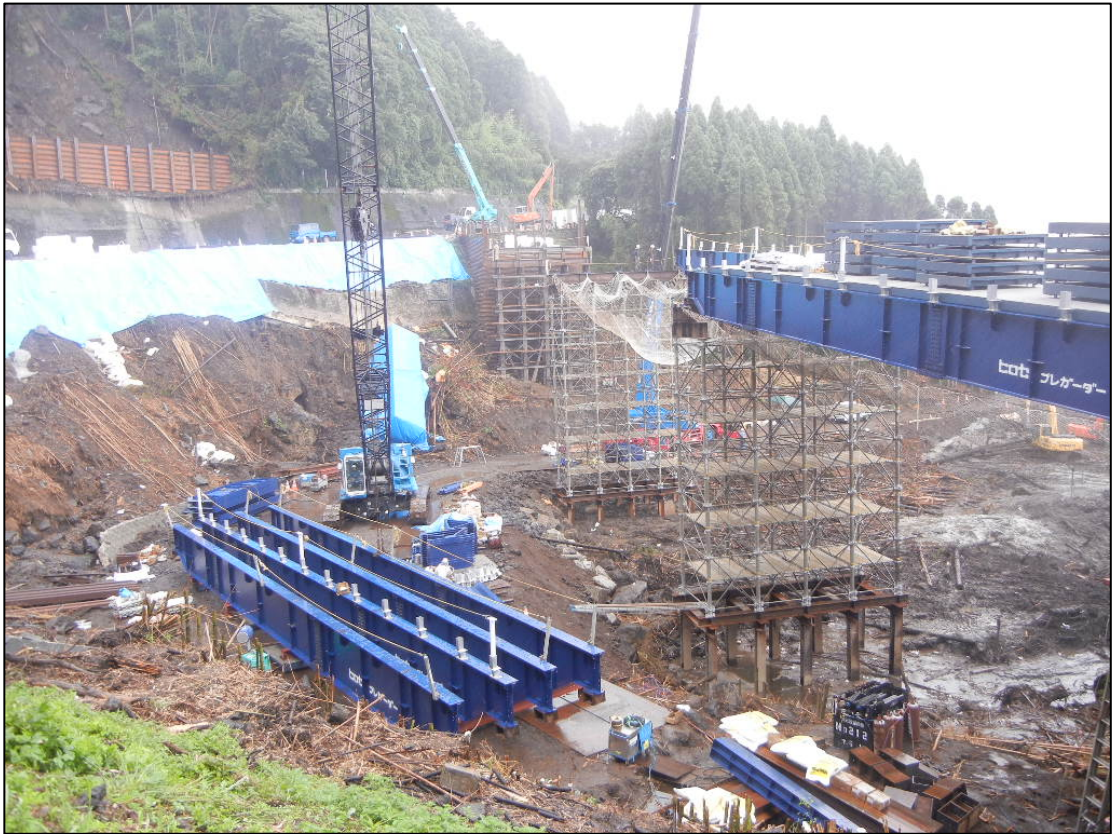
【写真－ 7】 仮橋の下部工（橋台・橋脚）工事完了
