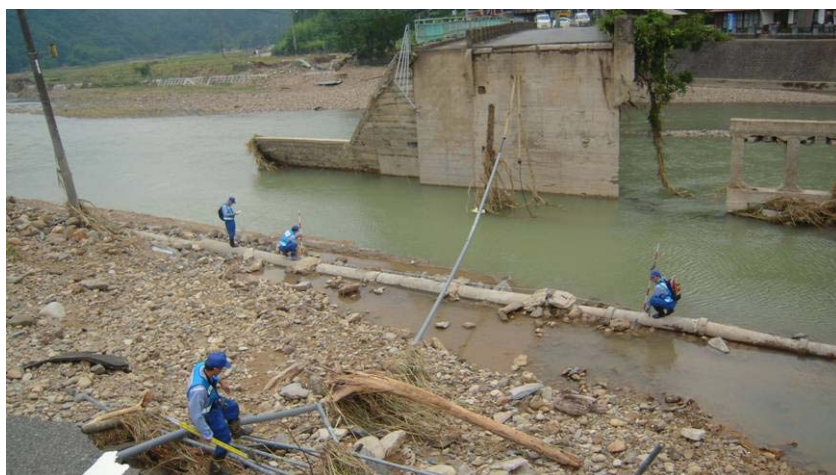
高岩橋右岸側
