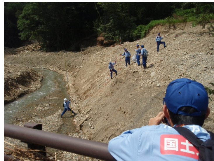
名賀川被災箇所の調査状況（河川2班）
