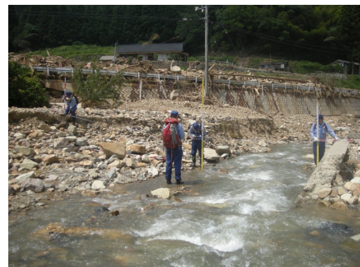
名賀川被災箇所の調査状況（河川2班）
