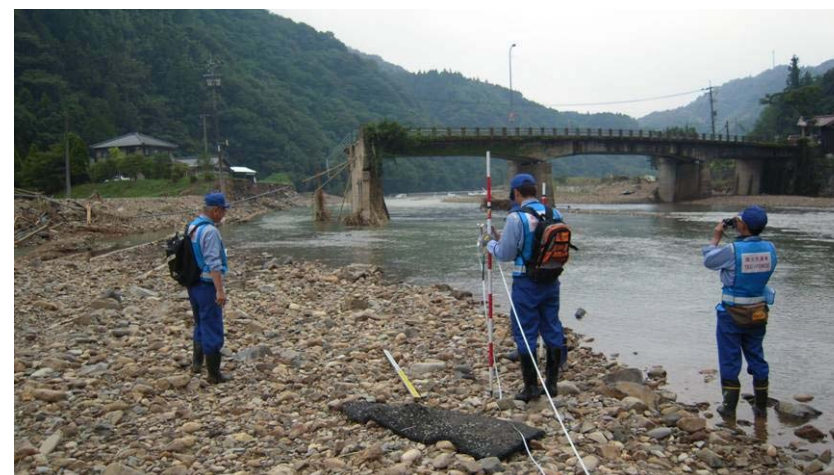
高岩橋下流側
