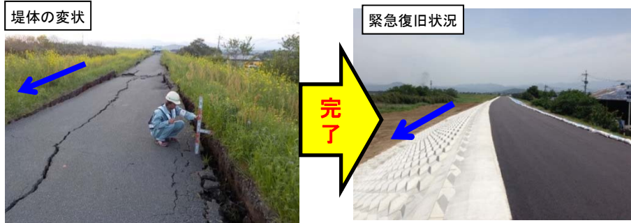
緊急災⑦ 4/30完了 緑川左岸 1 0 k 9 0 0 付近 (熊本市)
