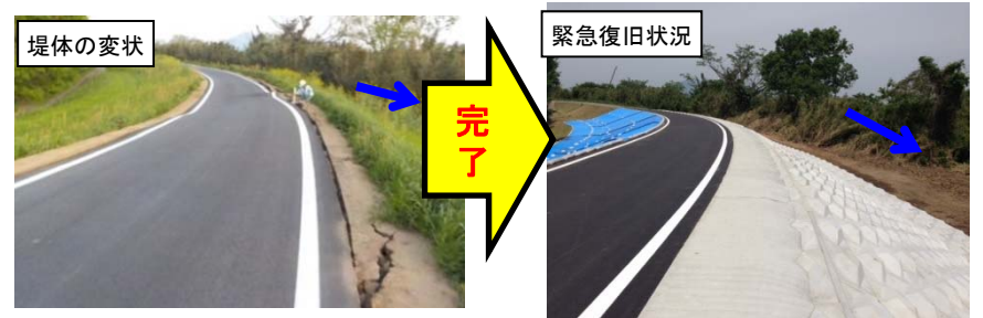
緊急災⑩ 4/30完了 緑川右岸 9 k 2 0 0 付近 (熊本市)
