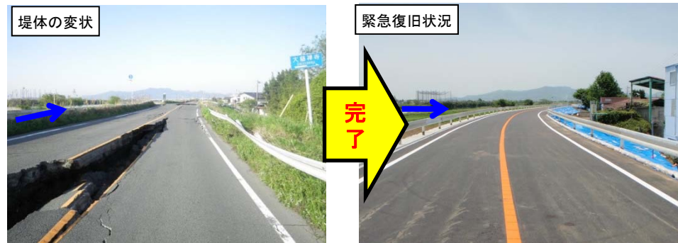
緊急災④ 4/30完了 緑川右岸 8k 900 付近 (熊本市)
