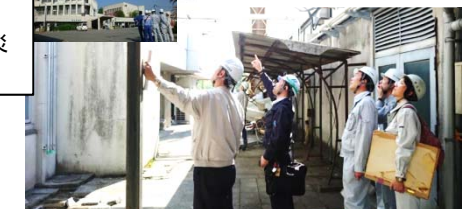
▼被災建築物の応急危険度判定 (建築物班)
