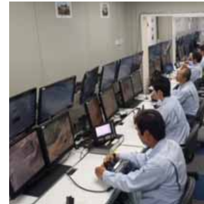
土留盛土工の無人化施工状況 (操作室の様子)
