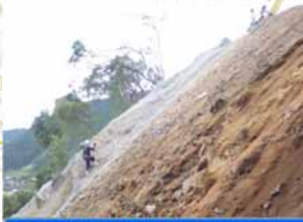
柵の木側 法面对策着手
