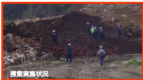
搜索支援および土砂撤去状況
