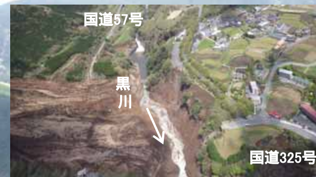
河道部の状況
