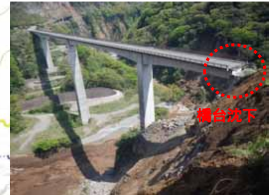
阿蘇長陽大橋の被災状況
