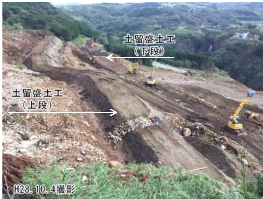
土留盛土工の造成（熊本側より望む）
