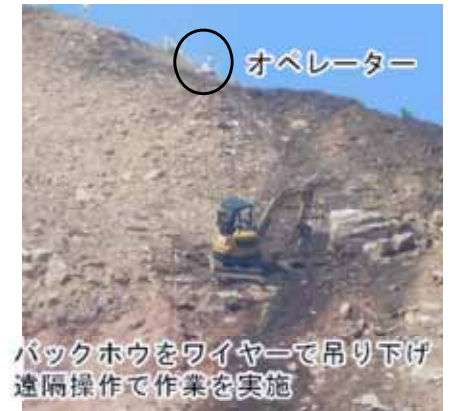
頂部のラウンディング状況 (高所法面掘削機での施工)
