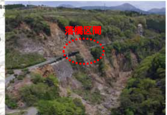
戸下大橋の被災状況
