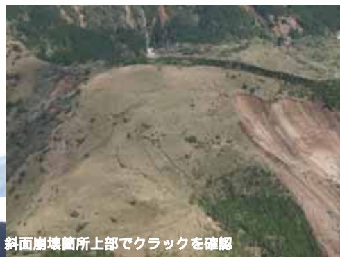
斜面崩壊箇所上部の状況
