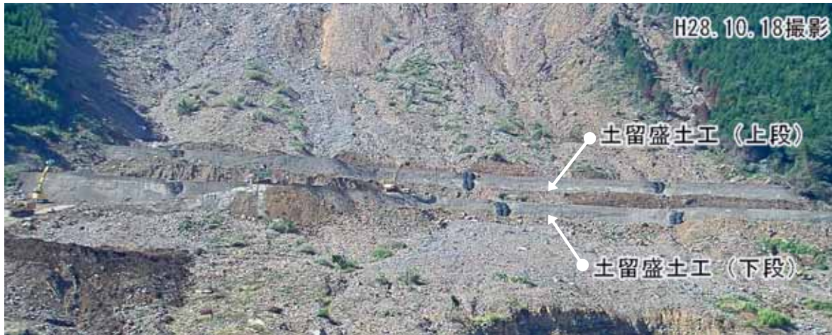
土留盛土工の全景（対岸より望む）
