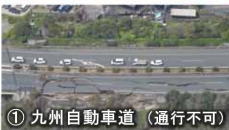
熊本地震の被害（益城町）
