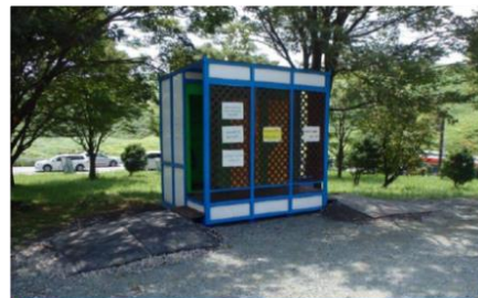
仮設トイレの設置
