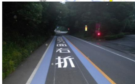
路面標示の設置
