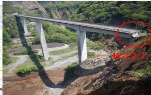
阿蘇長陽大橋の被災状況
