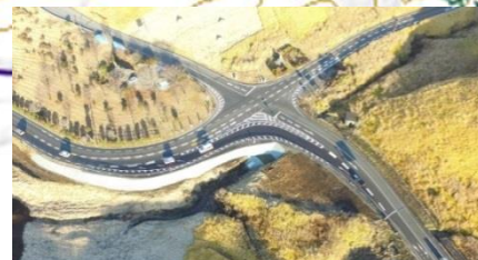
二重峠左折レーン設置
