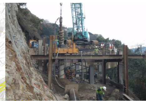
柵の木側 仮橋橋脚杭打ち状況
