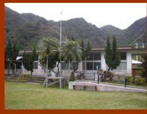
空き施設の有効活用
