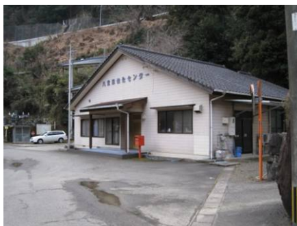
活性化センターの写真
