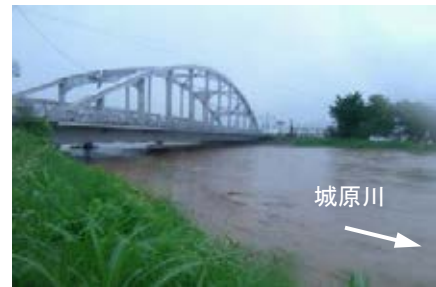
平成21年7月26日洪水の様子（神埼橋）
