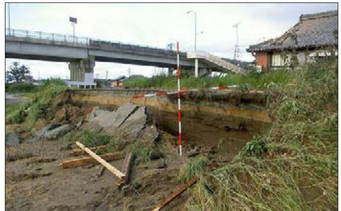
高潮による堤防法崩れ状況(平成18年台風13号)
