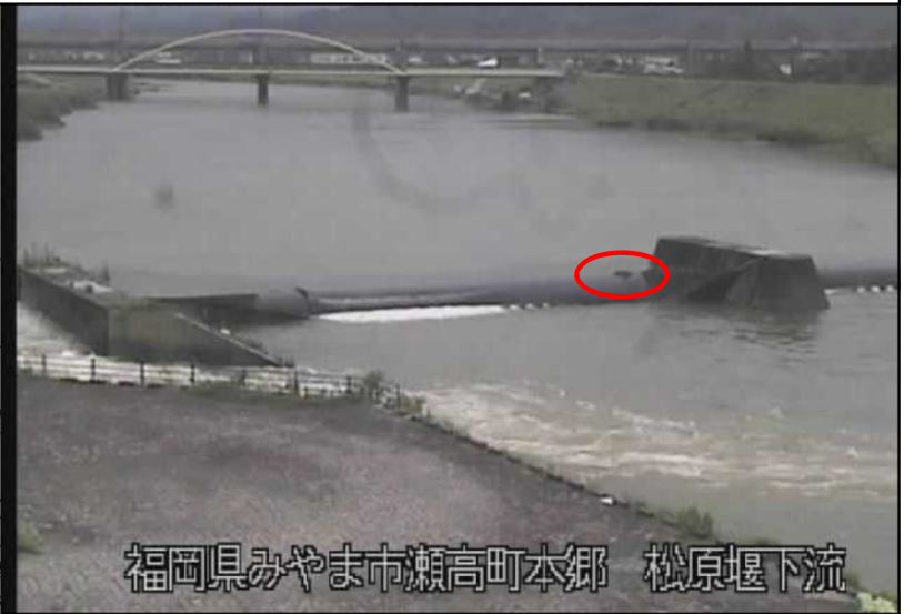
袋体の変状箇所全景
