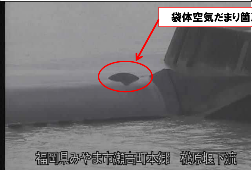
袋体の変状箇所近景
