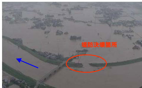
矢部川本川 津留橋付近【堤防決壊状況】
