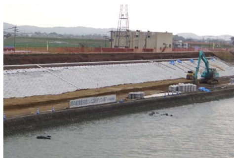
対策工法:法覆護岸工法
