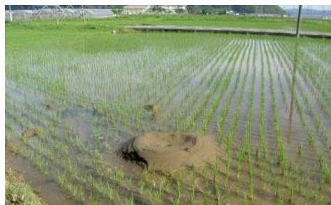
矢部川本川 噴砂発生状況
