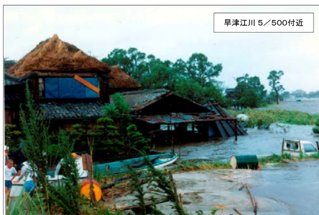
高潮による浸水状況(昭和60年台風13号)
