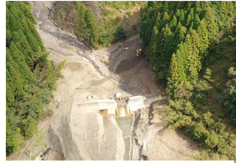
土砂の堆積状況 (小河内砂防堰堤)
