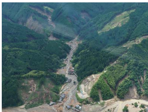
災害発生時（小河内川）
