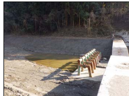
除石完了後 (H29. 12. 21 撮影)
