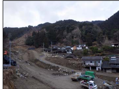
工事用道路整備後 (H29. 12. 26 撮影)
