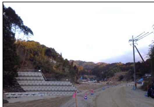
施工状況（H30. 1. 26 撮影）
