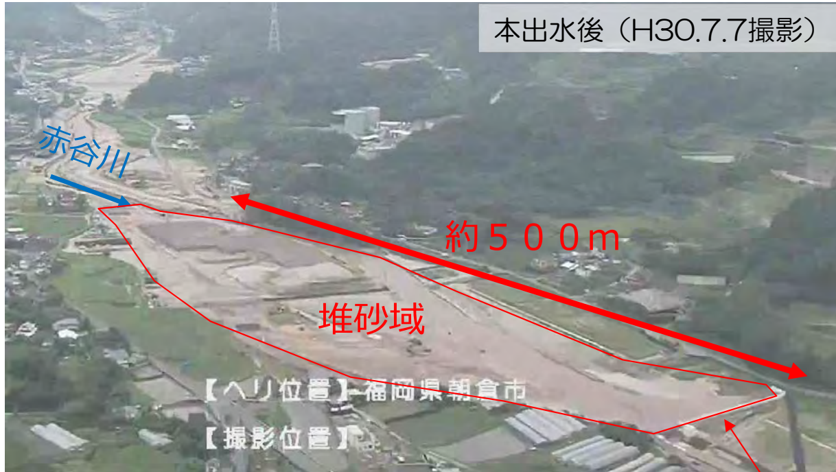
1号土砂止め工
