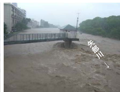
船小屋地区(矢部川15.4k付近)
