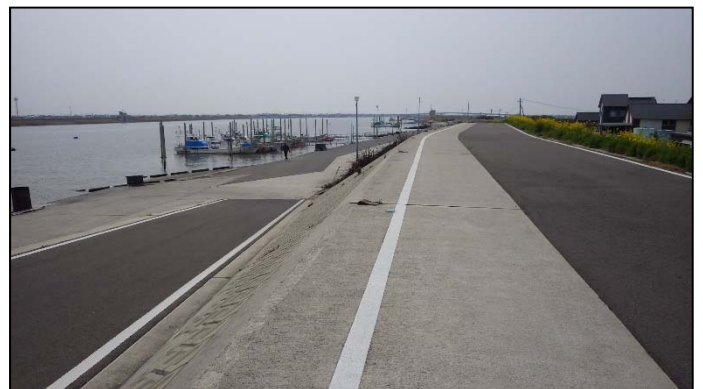
堤防整備の事例
