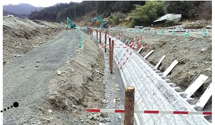
河川の災害復旧のイメージ(段階的な施工)
