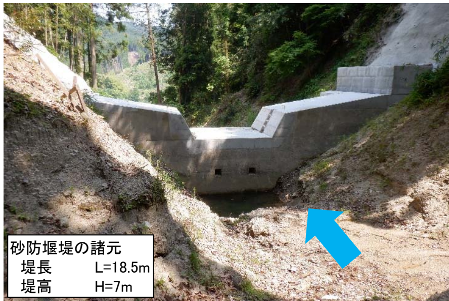
土砂捕捉前 (R2. 5. 28撮影)
