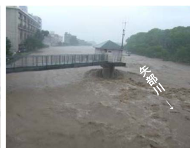
船小屋地区(矢部川15.4k付近)
