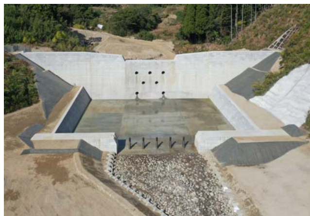
砂防堰堤の完成【赤谷16】(令和2年10月)
