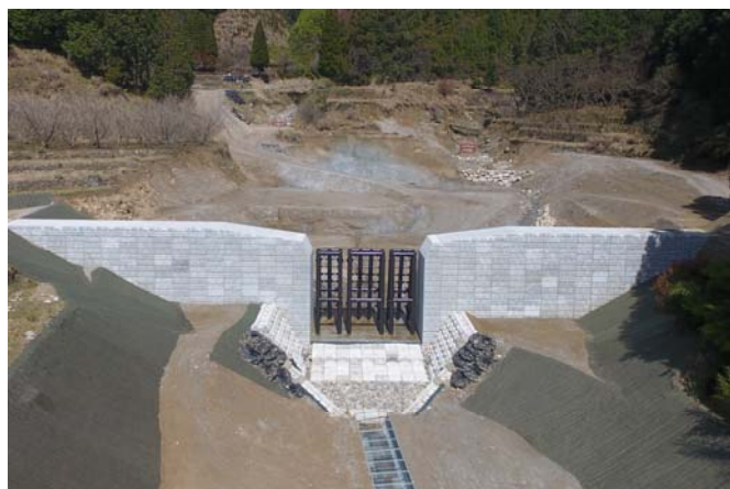
砂防堰堤の完成【乙石25・26】(令和2年3月)
