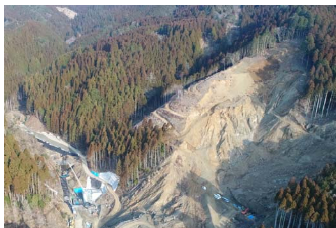
砂防堰堤・斜面对策 施工中【乙石15】(令和3年3月)
