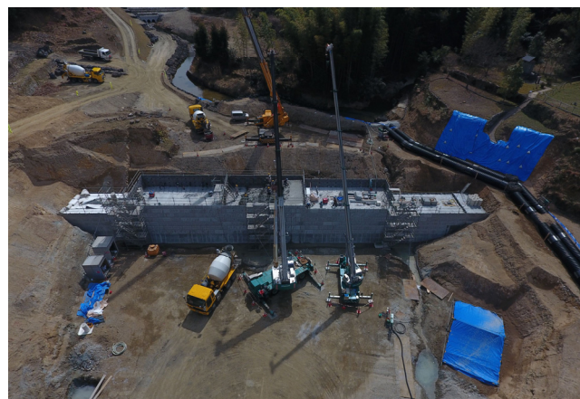
砂防堰堤 施工中【小河内川】(令和4年3月)
