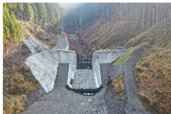
砂防堰堤の完成【赤谷35_2号堰堤】(令和3年11月)
