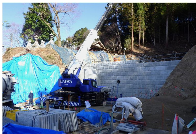
砂防堰堤 施工中【乙石31】(令和4年3月)
