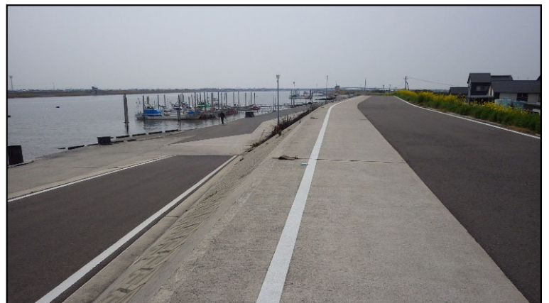
堤防整備の事例
