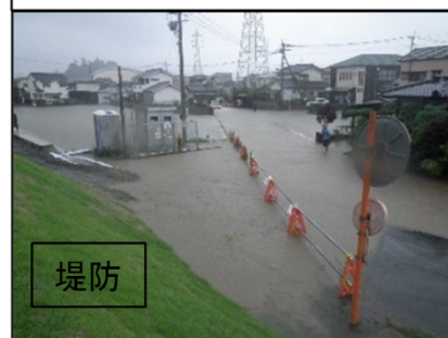
花月川右岸4k500 浸水状況(堤内地を望む)
