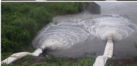
排水状況(大川市大字大野島) 6/30 21時~7/1 10時
