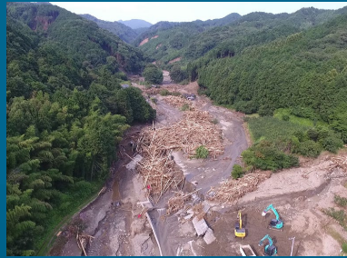
平成29年7月九州北部豪雨 (朝倉市)
