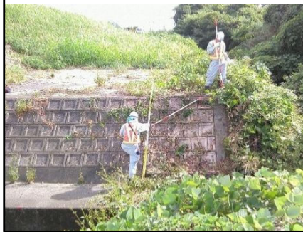
構造物等の点検(出水期前)
