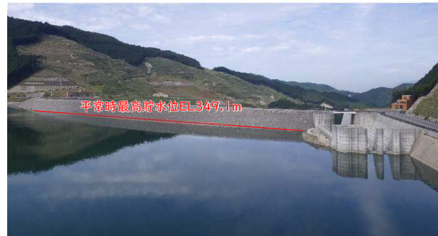
平常時最高貯水位付近の状況(R7.6.6:EL348.39m)
