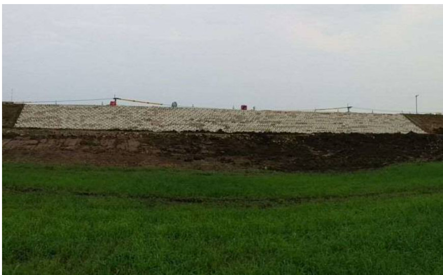
応急復旧工事完了(8月28日17:00)
