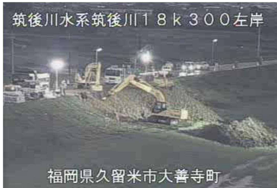
工事実施状況(8月25日19:00)
