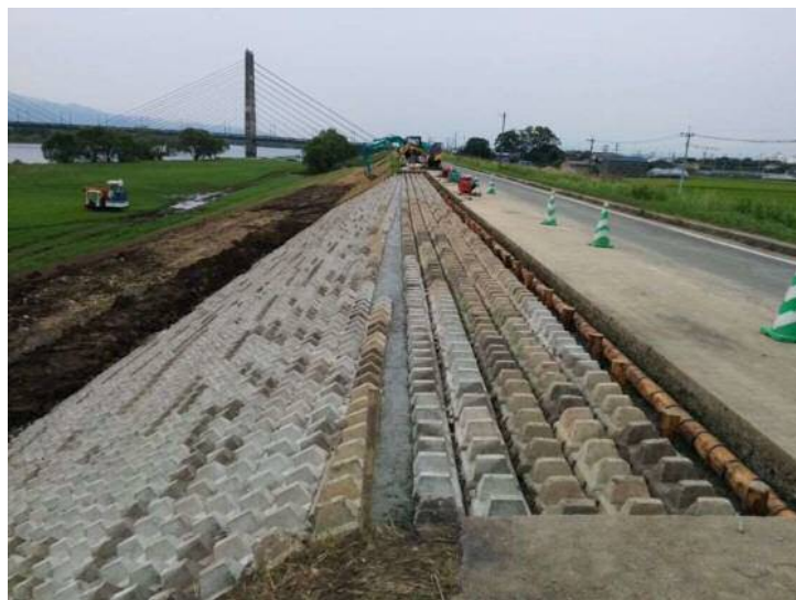
応急復旧工事完了(8月28日17:00)
