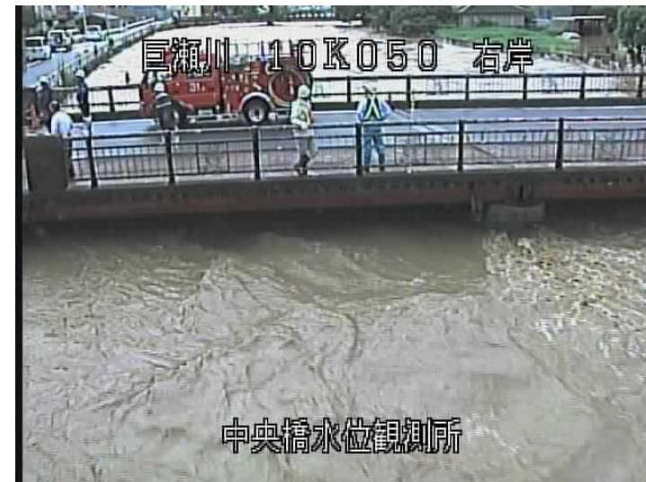
巨瀬川 10K050 中央橋水位観測所（久留米市） 7/14 9:12
