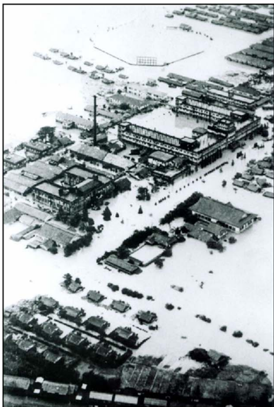
水没した久留米市街（医大付近）
