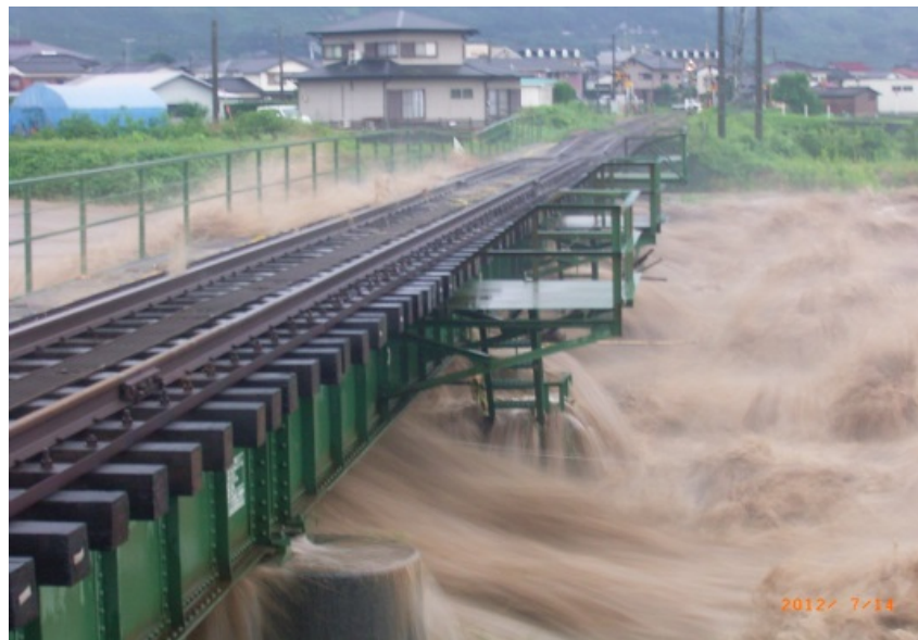
隈上川 1k400付近 JR久大本線橋梁（うきは市）
