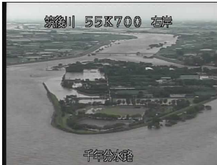
筑後川 55K700 千年分水路（朝倉市） 7/14 9:13
