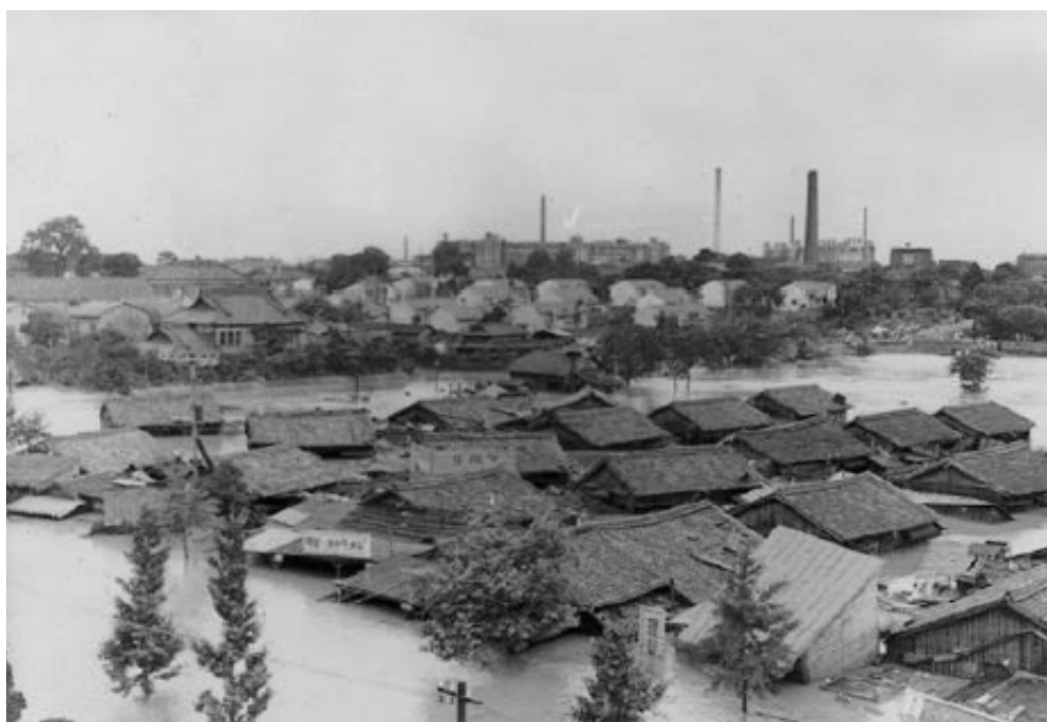
昭和28年6月西日本水害 久留米医大付近の浸水状況 (出典：「筑後川河童の思い出」なつかしい中流域写真集)
