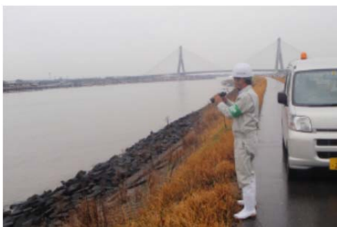
河川の巡視状況
