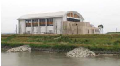
久留米西部河川防災ステーション
