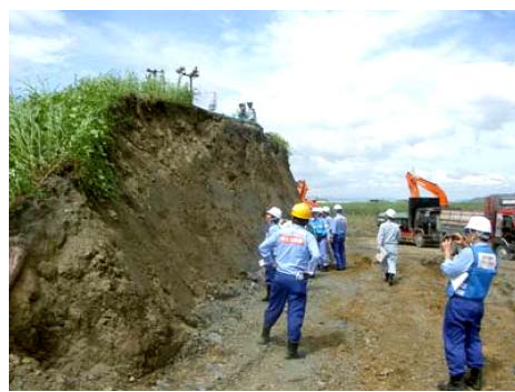
河川の被災状況調査
