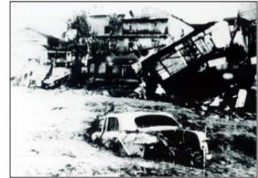
壊滅的な被害を受けた原鶴温泉街
