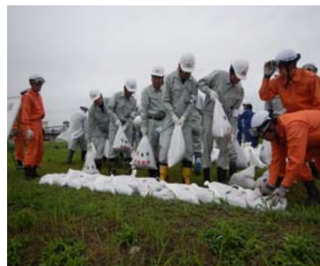
積み土嚢工法
