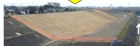
【激特】矢部川高柳地区築堤工事(平成28年3月)
