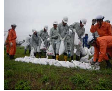
積み土嚢工法
