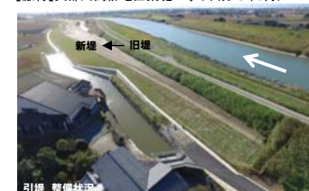
【大規模関連】矢部川泰仙寺地区築堤工事(平成28年11月)
