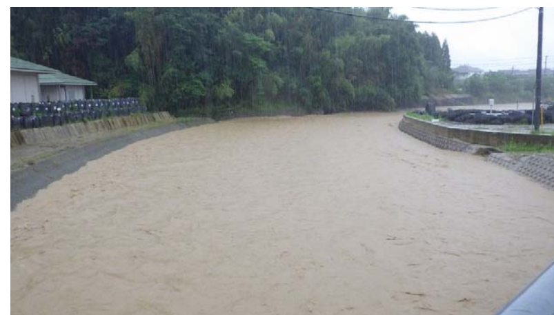
1号土砂止め工下流（杷木浄水場前）
