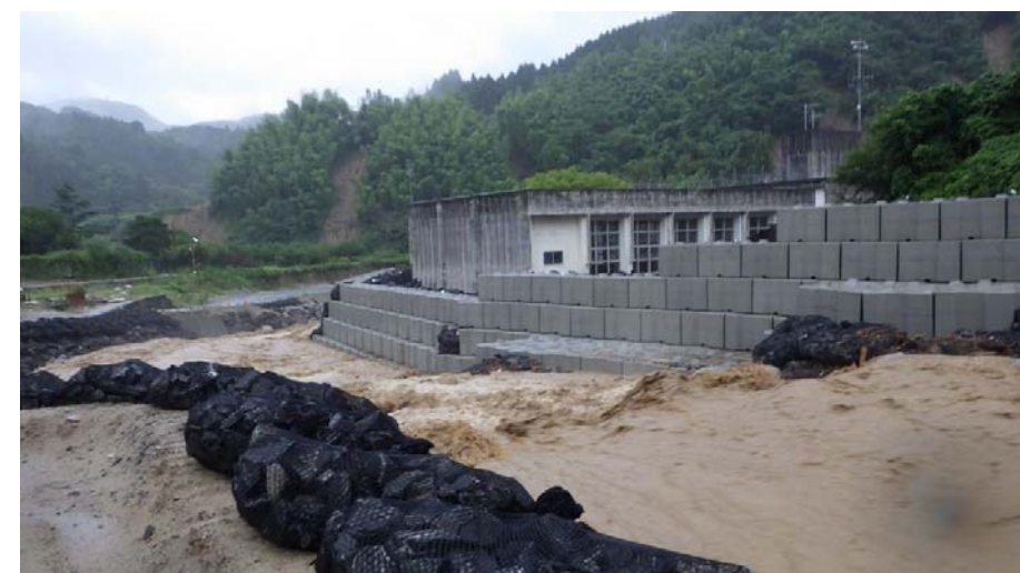
乙石川遊砂地下流（松末小学校付近）
