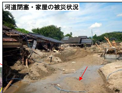
河道閉塞・家屋の被災状況
