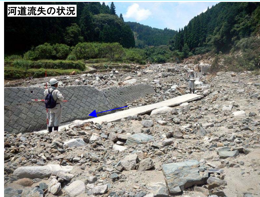
護岸の損傷状況
