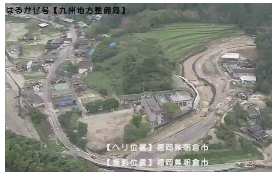
乙石川遊砂地下流（松末小学校付近）
