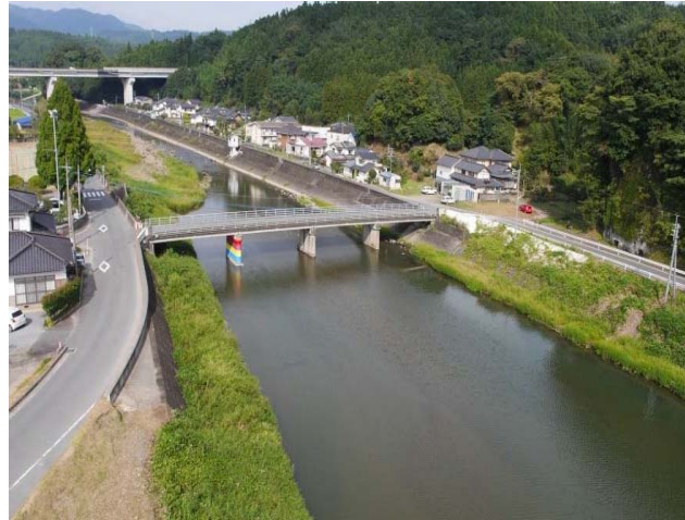
花月川激甚災害対策特別緊急事業による夕田橋の架替
