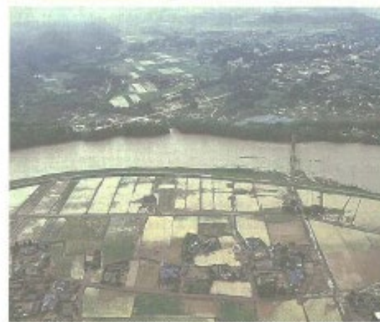
球磨川の氾濫（左：八木）で水没した入所者（中：中津市）と球磨川（右：球磨川町）の市村境付近。2020年7月豪雨、球磨川氾濫。2020年7月豪雨、球磨川氾濫。
