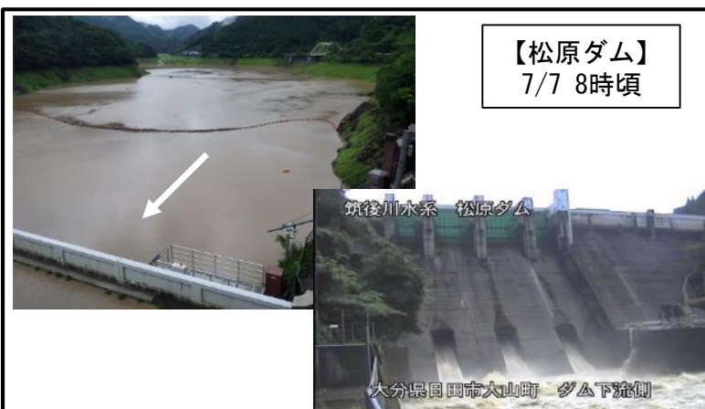
【松原・下笠ダムの操作状況】
