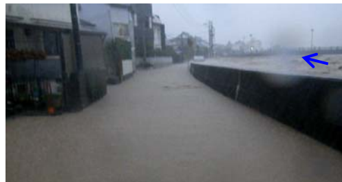
花月川左岸3k800付近
