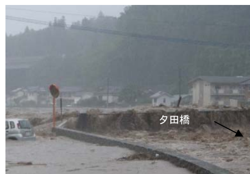
夕田橋 流木によるせき上げ 花月川4k600
