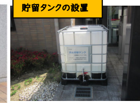
貯留タンクの設置
