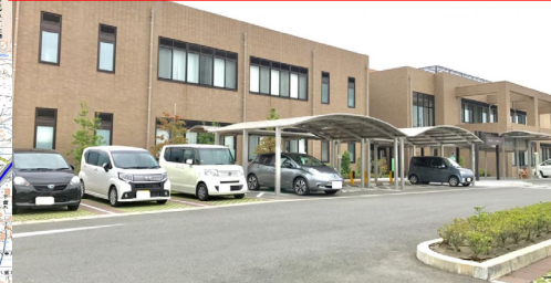
久留米市役所 田主丸総合支所
