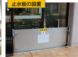
止水板の設置
