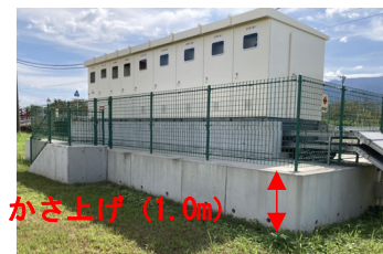
電気機器等の設置高所化事例
