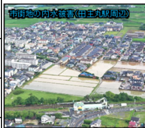
▲R5.7洪水における浸水被害状況
